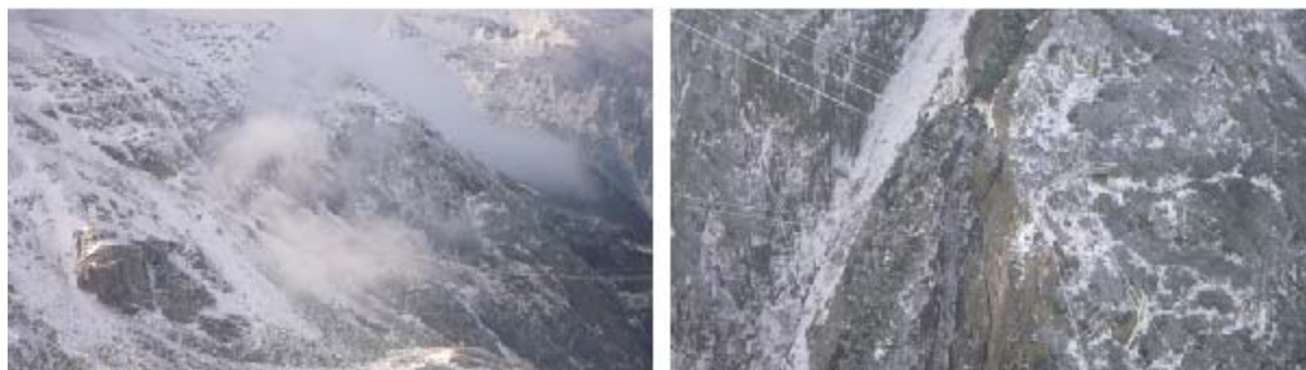
Die Stromleitung verschwindet in Wolken Überflug der Leitung an einer Mastspitze
